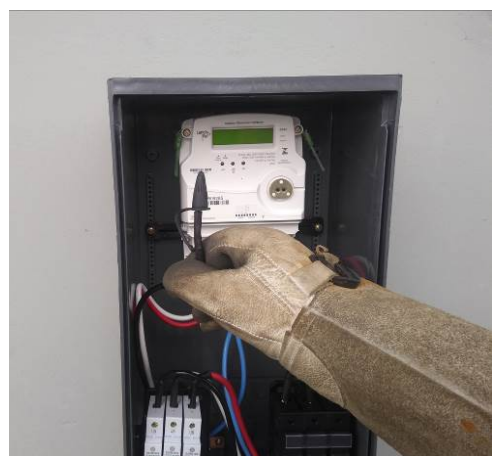
Figura 2 – Isolamento do condutor
